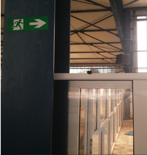
Κεντρικός χώρος πισίνας
