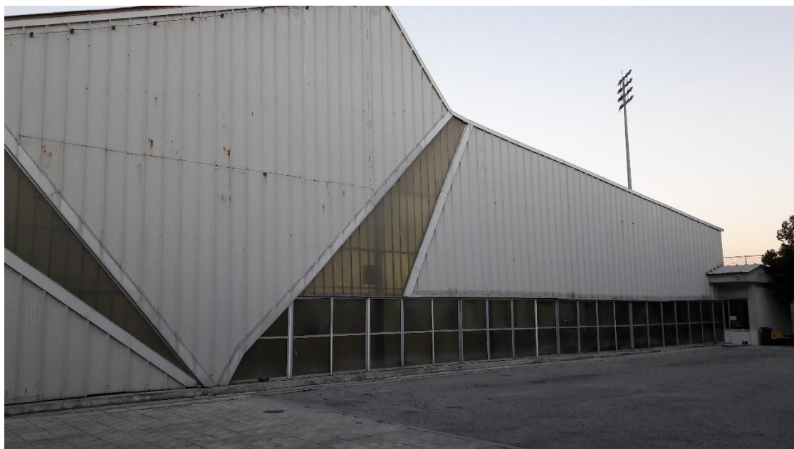
Εικόνα 3.1: Ν.Α πλευρά του κολυμβητηρίου
