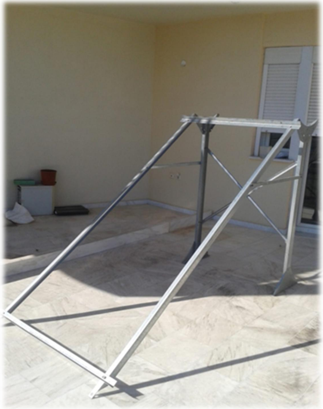
Εικόνα 3.5: Τελική μορφή της βάσης του ηλιακού θερμικού συστήματος.
