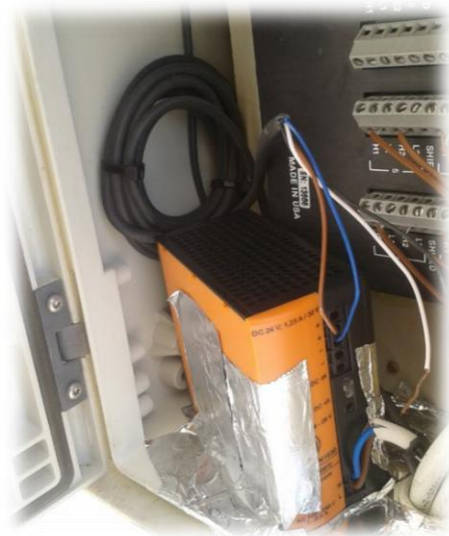
Εικόνες 3.36 – 3.37: Τροφοδοτικό Η/Μ ροόμετρον (αριστερά) και ο ροοστάτης για τον κυκλοφορητή (δεξιά).
