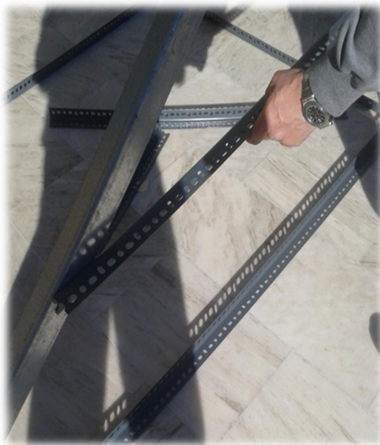
Εικόνα 3.11: Εργασίες διαμόρφωσης της βάσης στήριξης.
