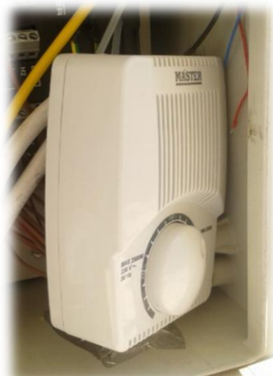
Εικόνες 3.36 – 3.37: Τροφοδοτικό Η/Μ ροόμετρον (αριστερά) και ο ροοστάτης για τον κυκλοφορητή (δεξιά).
