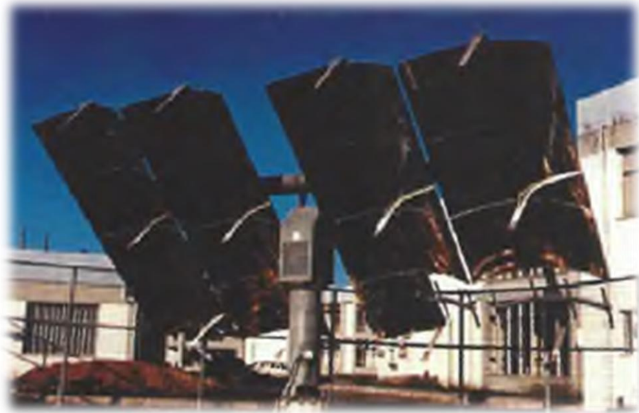
Εικόνα 2.5: Συγκεντρωτικός ηλιακός συλλέκτης μέσης ισχύος.
