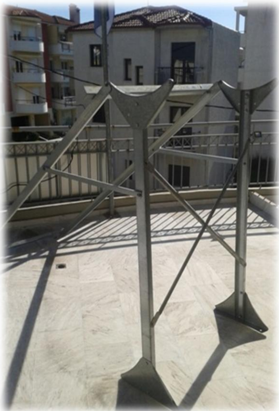
Εικόνες 3.2 – 3.3 – 3.4: Στάδια συναρμολόγησης της βάσης του ηλιακού θερμικού συστήματος.
