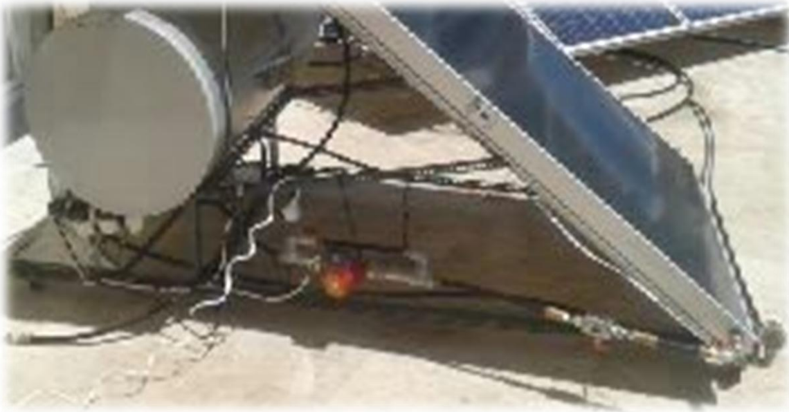
Εικόνα 3.30: Τοποθέτηση ηλεκτρομαγνητικού ροόμετρου.
