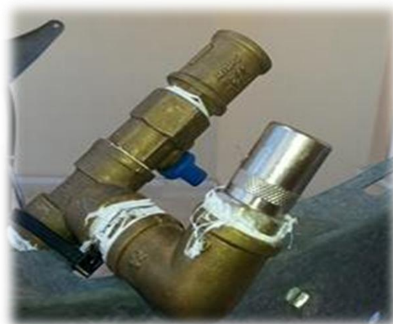
Εικόνα 3.25: Τοποθέτηση εξαεριστικού στο υψηλότερο σημείο του ηλιακού θερμικού συστήματος.
