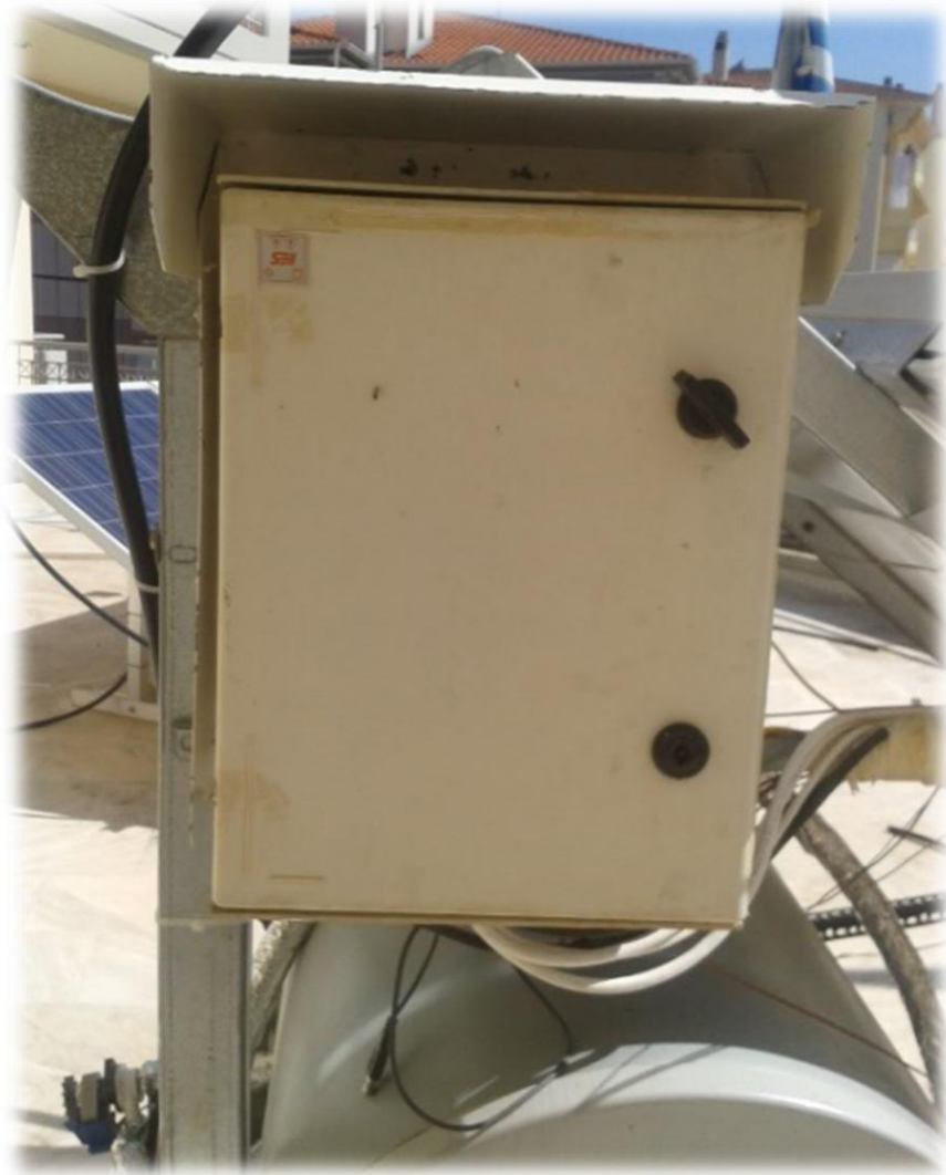
Εικόνα 3.34: Τοποθέτηση Data Logger στην βάση στήριξης του συστήματος.
