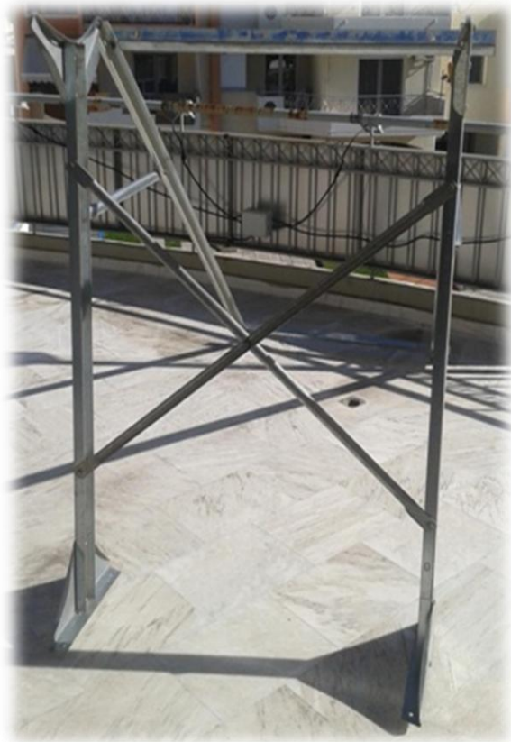
Εικόνες 3.2 – 3.3 – 3.4: Στάδια συναρμολόγησης της βάσης του ηλιακού θερμικού συστήματος.
