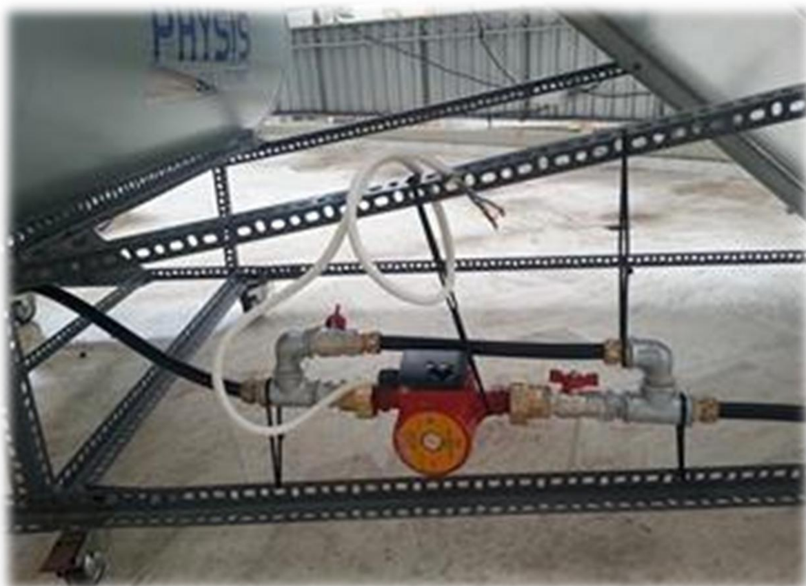
Εικόνα 3.28: Τοποθέτηση κυκλοφορητή μεταξύ του συλλέκτη και της δεξαμενής αποθήκευσης.
