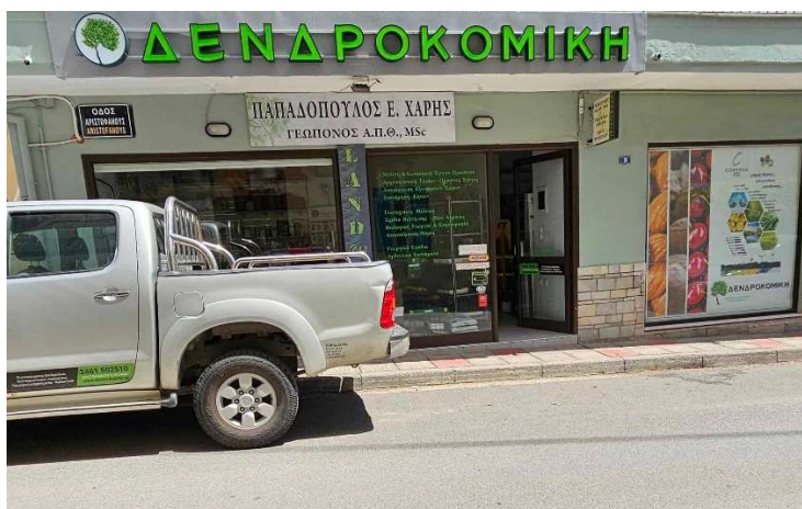
Εικόνα 3.2: Πρόσψη του Κτιρίου II
