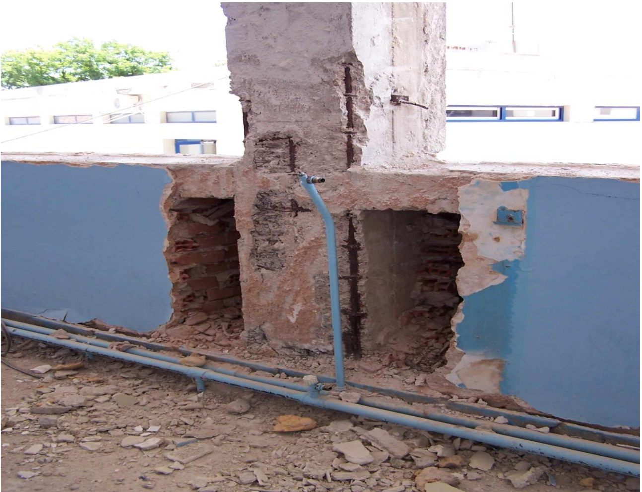
Εικόνα 2: ΔΙΑΝΟΙΞΗ ΤΟΙΧΟΠΟΙΙΑΣ ΩΣΤΕ ΝΑ ΔΙΕΥΚΡΙΝΙΣΤΕΙ Ο ΤΡΟΠΟΣ ΔΟΜΗΣΗΣ ΤΗΣ ΤΟΙΧΟΠΟΙΙΑΣ
