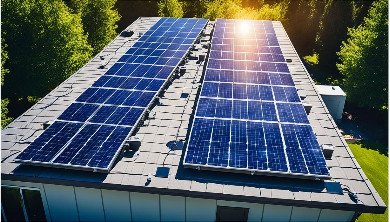
Εικόνα 27: ΕΓΚΑΤΕΣΤΗΜΕΝΟ ΦΩΤΟΒΟΛΤΑΪΚΟ ΣΥΣΤΗΜΑ ΣΕ ΣΤΕΓΗ, www.blog.leditnow.gr
