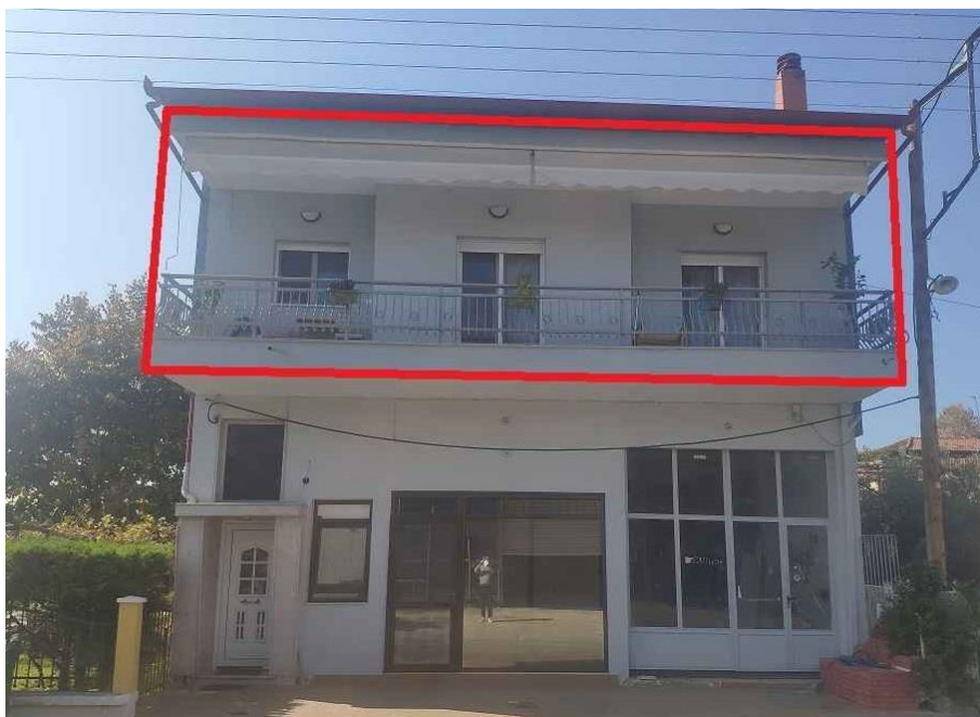
ΕΙΚΟΝΑ 24: NZEB ΚΑΤΟΙΚΙΑ ΣΤΗΝ ΚΡΥΑ ΒΡΥΣΗ ΠΕΛΛΑΣ
