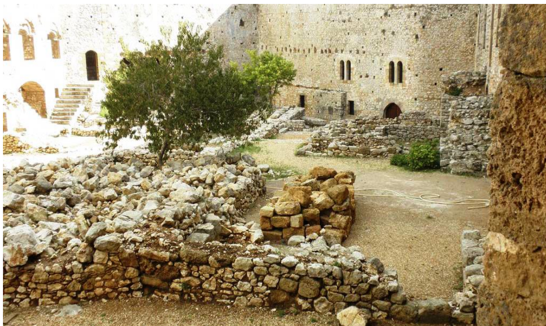
Εικόνα 19: Εσωτερικός περίβολος. Πηγή: www.google.gr
