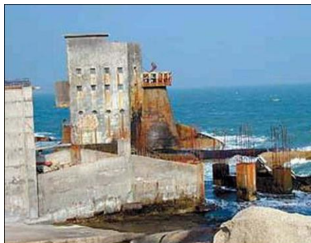
Σχήμα 1.11: Εγκατάσταση συσκευής OWC στην Κίνα
