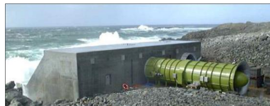
Σχήμα 1.10: Εγκατάσταση στο νησί Islay
