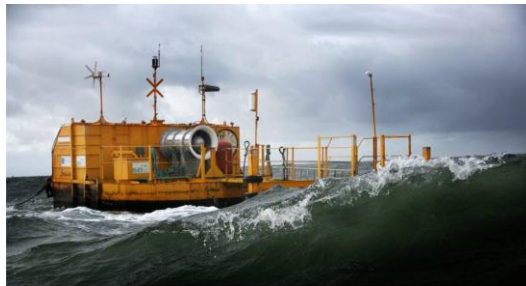
Σχήμα 1.16: BBDB OWC συσκευή κλίμακας 1/4 εξοπλισμένη με στρόβιλο Wells στο Galway Bay
