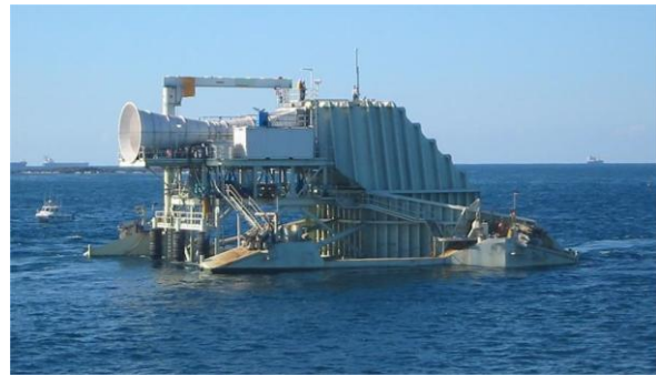
Σχήμα 1.14: Προέκταση τοιχωμάτων συσκευής OWC στην Αυστραλία
