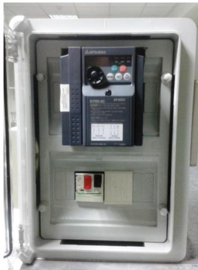
Σχήμα Ε.2: Ρυθμιστής στροφών ανεμιστήρα (inverter) {7}
