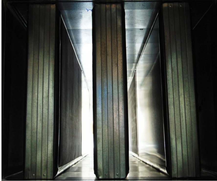
Σχήμα E.9: Εσωτερικό ηχοπαγίδας, τριών ηχοστοιχείων 100mm {7}
