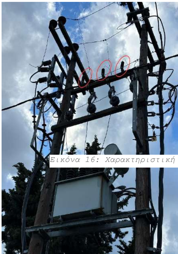
Εικόνα 18: Εκτροπέες υπέρτασης σε μετασχηματιστή υποβιβασμού τάσης
