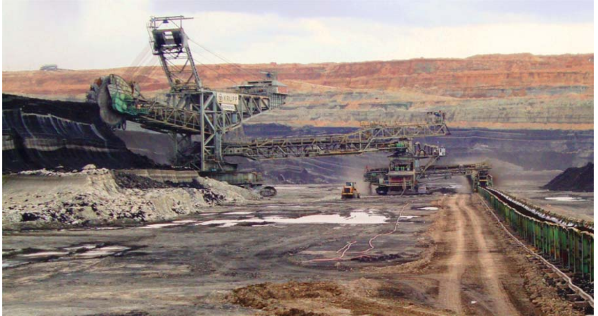
Εικόνα 3 . 8 Η χρήση αποθετών είναι η απομάκρυνση του αφαιρούμενου υλικού από το χώρο εξόρυξης στους χώρους απόθεσης και στη συνέχεια στους ταινιόδρομους
