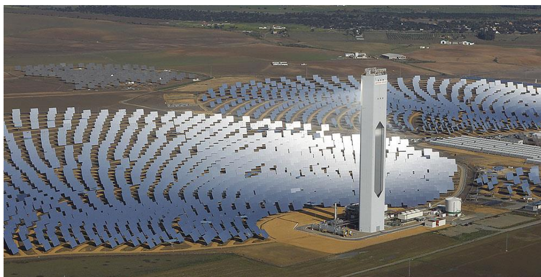
Σχήμα 2.18 Ηλιοστατικό πεδίο προσανατολισμένο βόρεια του πύργου-δέκτη ( energiasrenovadas.com )
