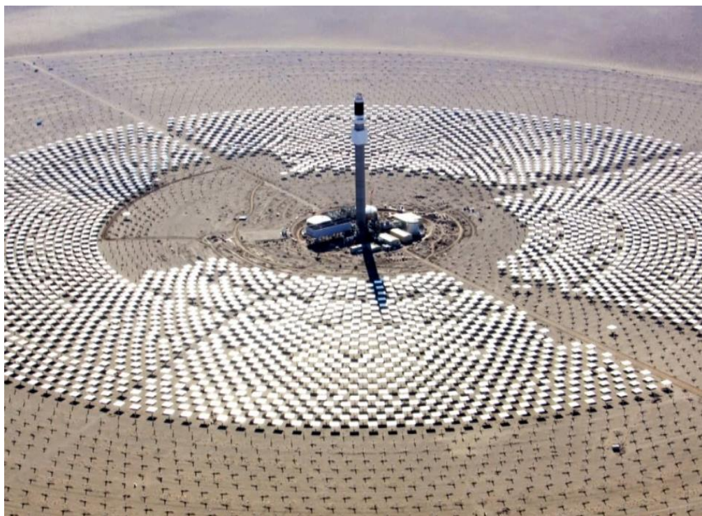
Σχήμα 2.17 Ηλιοστατικό πεδίο περιμετρικά από τον πύργο-δέκτη ( america.aljazeera.com )
