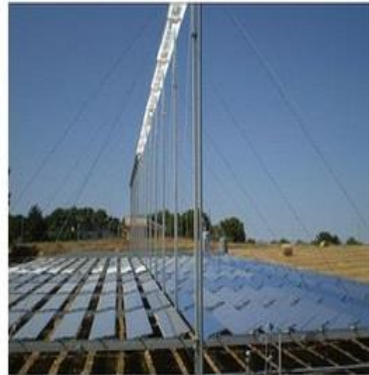
Σχήμα 2.11 Ηλιακοί συλλέκτες με γραμμικούς ανακλαστήρες τύπου Fresnel ( www.intechopen.com )
