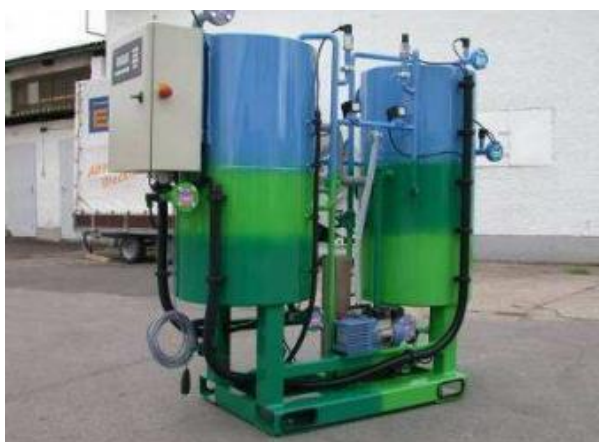
Σχήμα 6.1 EAW WEGRACAL SE 15 Ψύκτης απορρόφησης διαλύματος LiBr - H_2O ψυκτικής ισχύος 15kW (Eaw-Energieanlagenbau)
