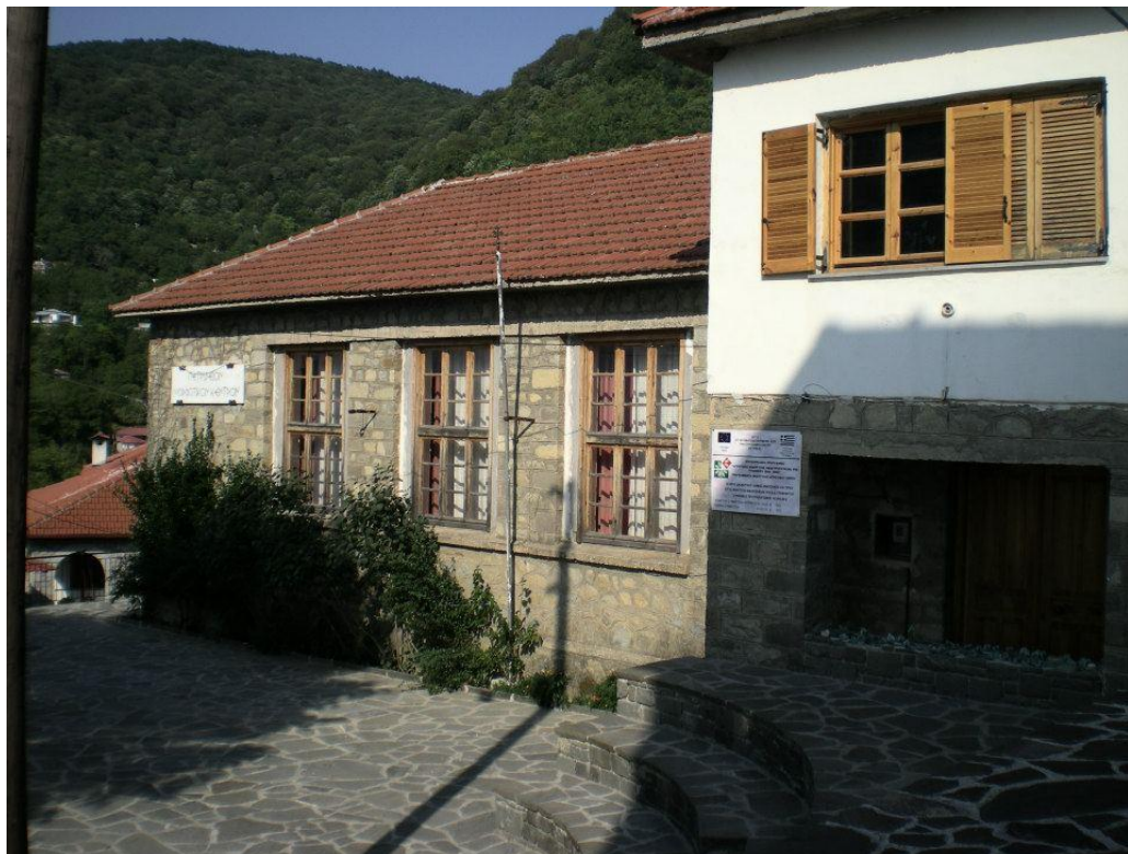
Εικόνα 15: Πετρίδαιο Μορφωτικό Κέντρο Γρεβεντίου
