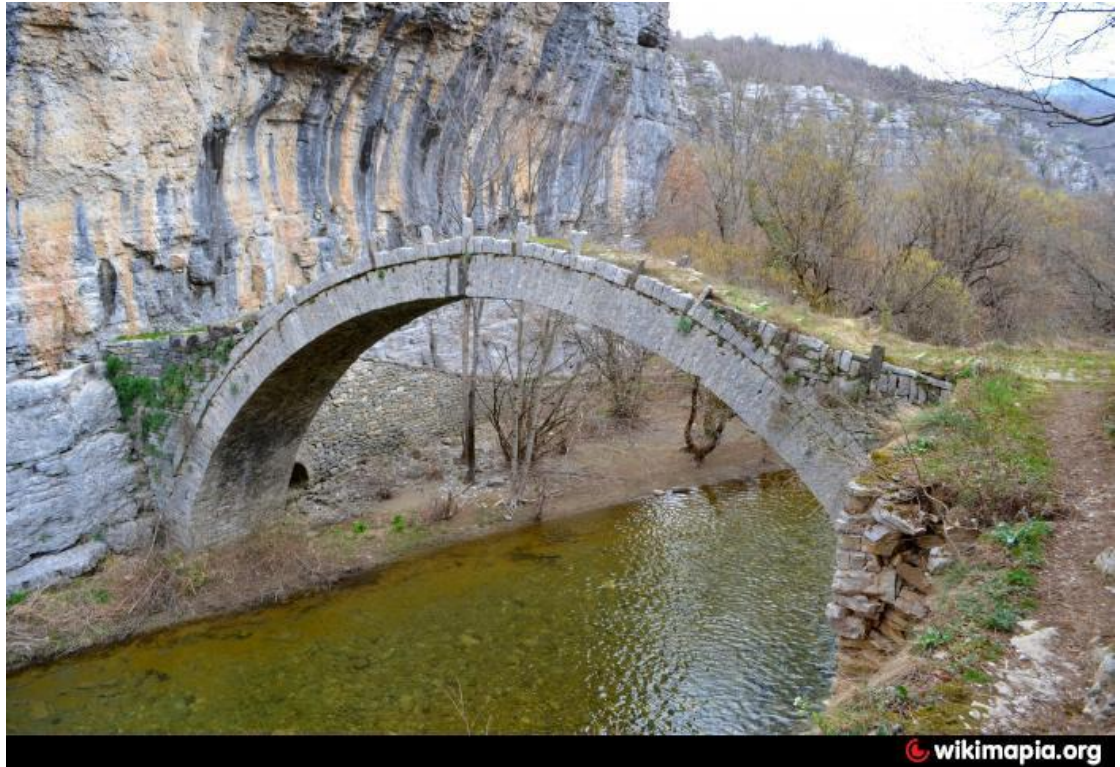
Εικόνα 8: Γεφύρι Κοντοδήμου ή Λαζαρίδη στο Κουκούλι
