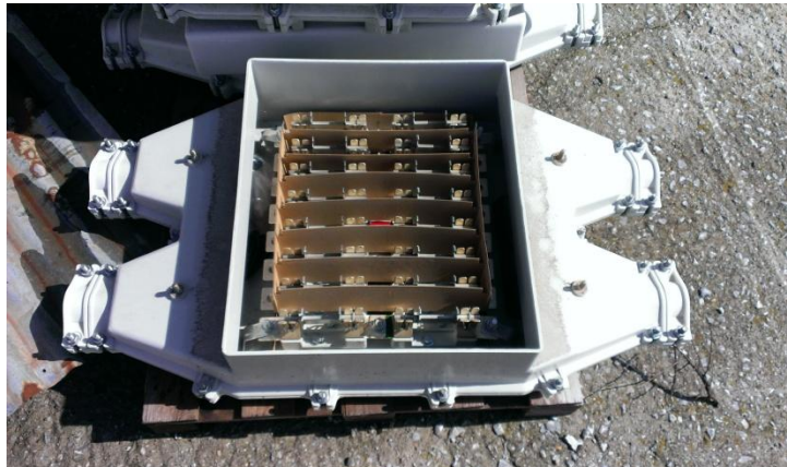
Φωτογραφία 4.15 Κιβώτιο ζεύξης 4 αναχωρήσεων υπόγειων καλωδίων XT
