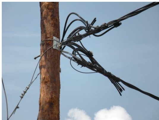
Φωτογραφία 4.8 Τερματισμοί ΣΝ καλωδίου 4x120
