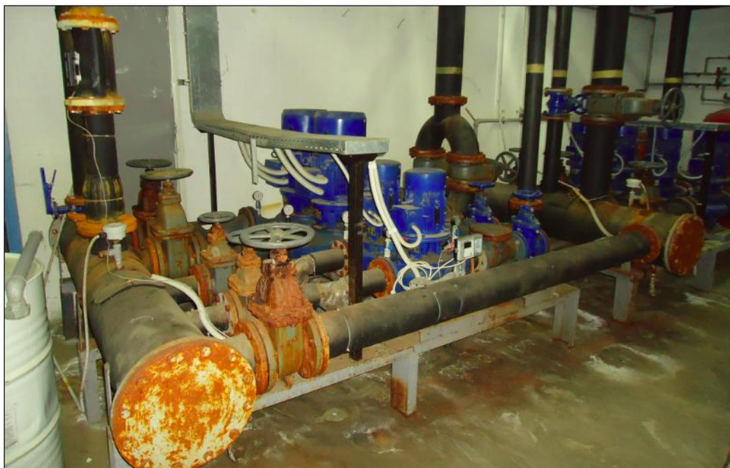
Εικόνα 6.7: Συλλέκτες και αντλίες
