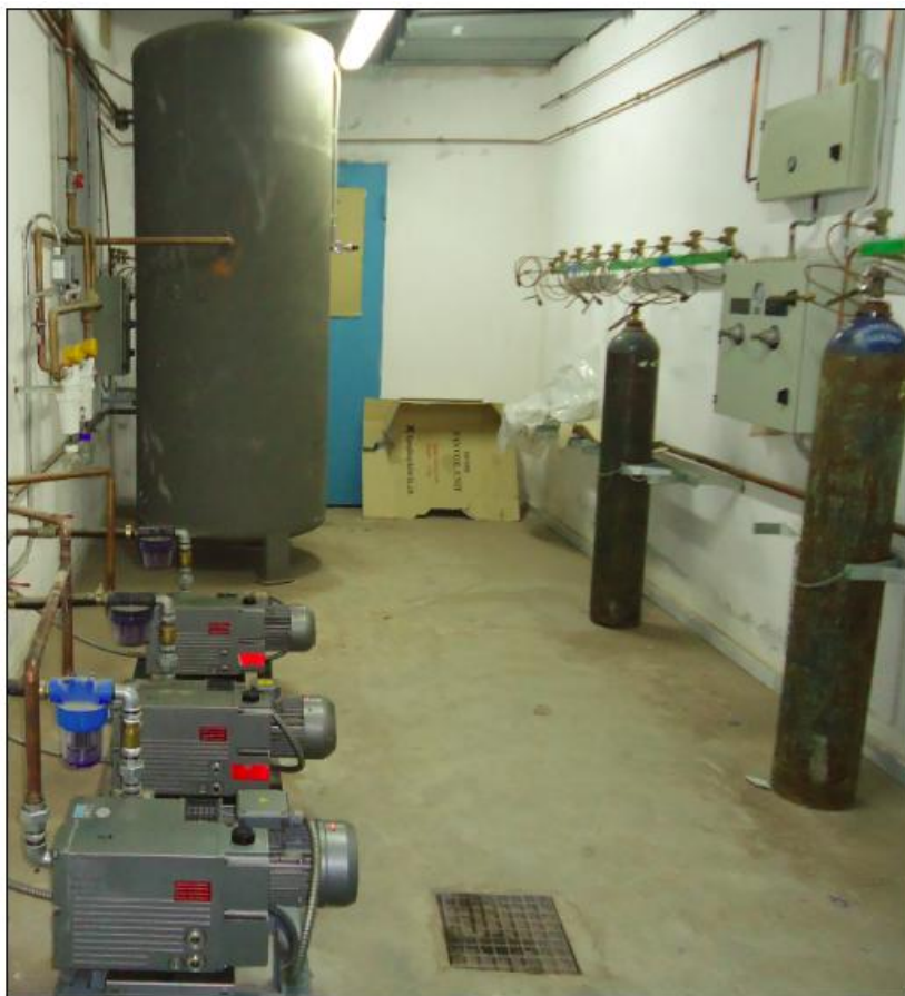
Εικόνα 3.4: Μπουκάλες πρωτοξειδίου του αζώτου και συμπιεστές κενού
