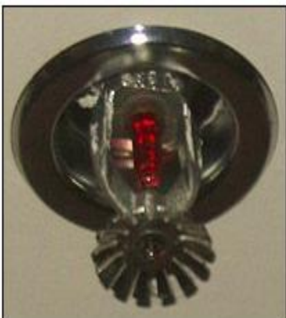
Εικόνα 5.4: Καταιονητήρας
