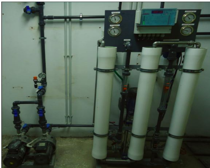
Εικόνα 3.7: Συσκευή αντίστροφης ώσμωσης
