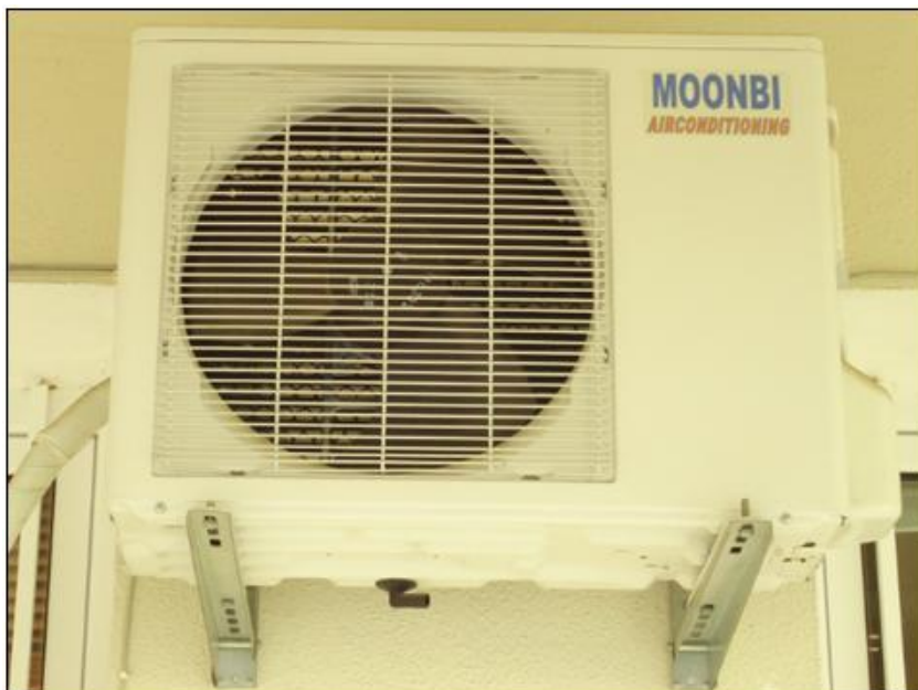
Εικόνα 6.11: Κλιματιστικό σώμα (split unit)
