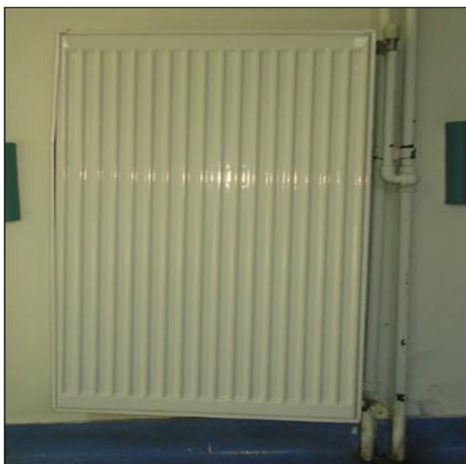
Εικόνα 6.12: Θερμαντικό σώμα τύπου Panel
