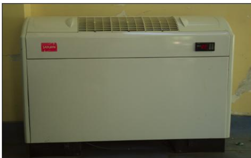
Εικόνα 6.13: Fancoil Unit
