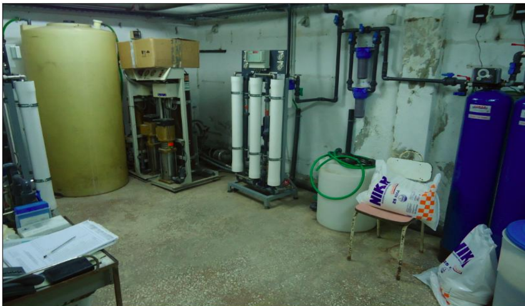
Εικόνα 3.5: Χώρος πραγματοποίησης διαδικασίας αντίστροφης ώσμωσης
