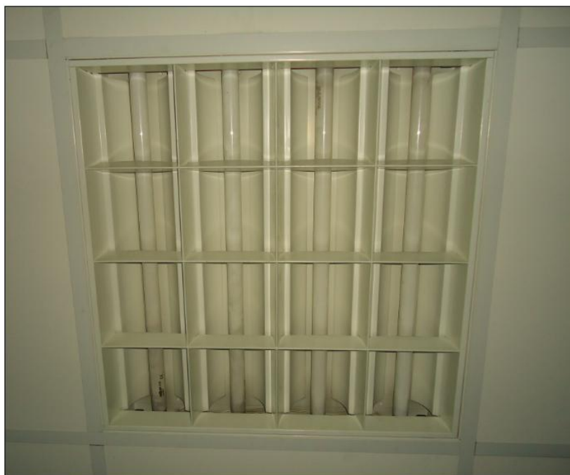
Εικόνα 7.2: Λαμπτήρες φθορισμού
