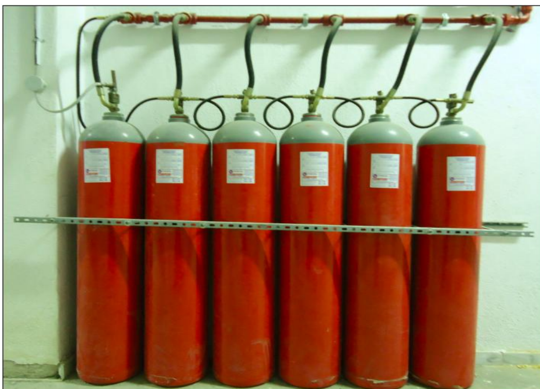
Εικόνα 5.5: Μόνιμο πυροσβεστικό συγκρότημα ξηρής σκόνης (μόνιμες-μεγάλες φιάλες)
