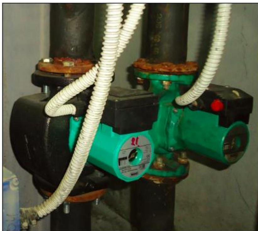
Εικόνα 6.6: Κυκλοφορητής
