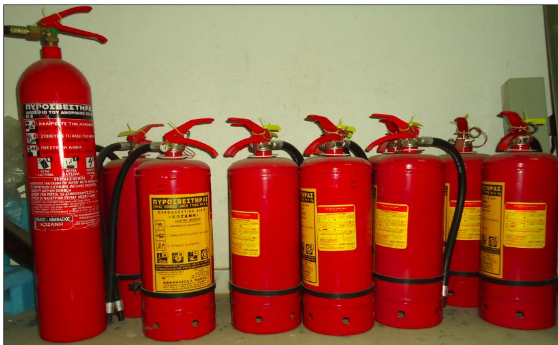
Εικόνα 5.6: Μόνιμο πυροσβεστικό συγκρότημα ξηρής σκόνης (φορητές-μικρές φιάλες-πυροσβεστήρες)
