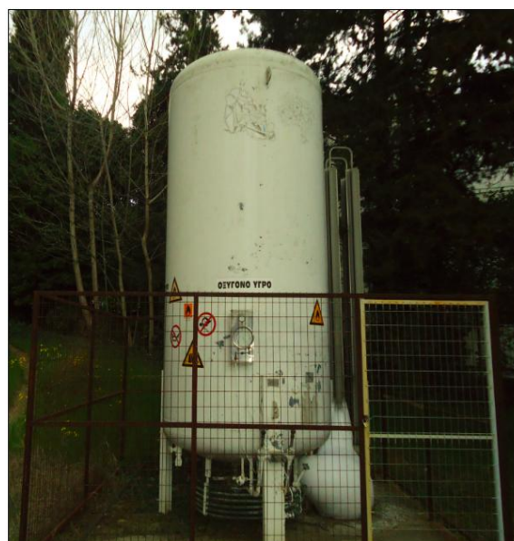
Εικόνα 3.1: Συστοιχίες φιαλών οξυγόνου Εικόνα 3.2:Κύρια δεξαμενή οξυγόνου
