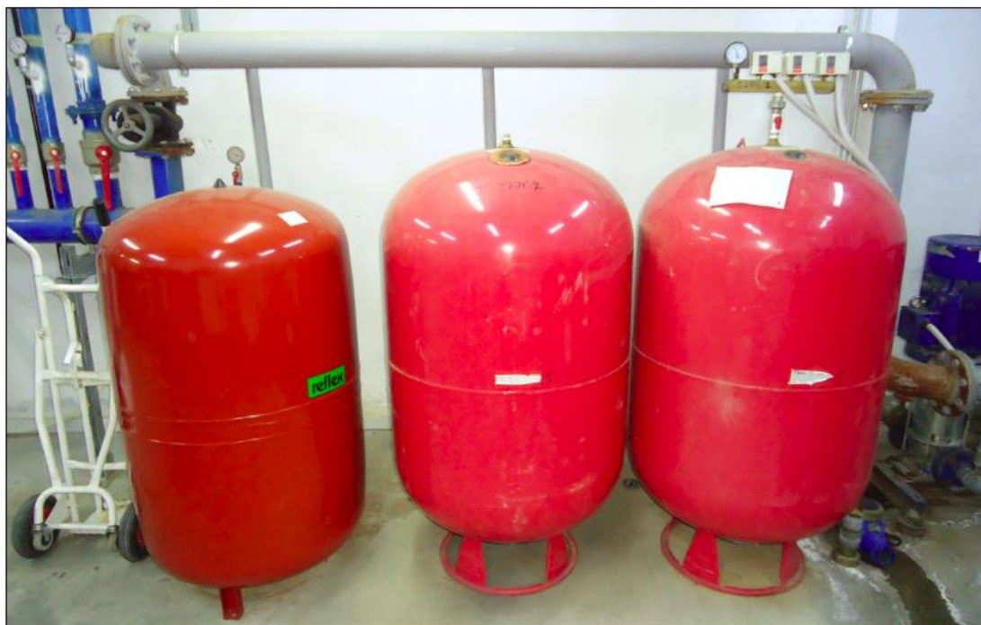
Εικόνα 6.3: Δοχεία διαστολής
