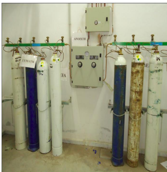
Εικόνα 3.1: Συστοιχίες φιαλών οξυγόνου Εικόνα 3.2:Κύρια δεξαμενή οξυγόνου
