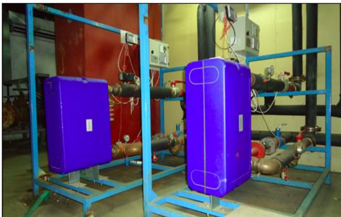
Εικόνα 6.1: Εναλλάκτες τηλεθέρμανσης
