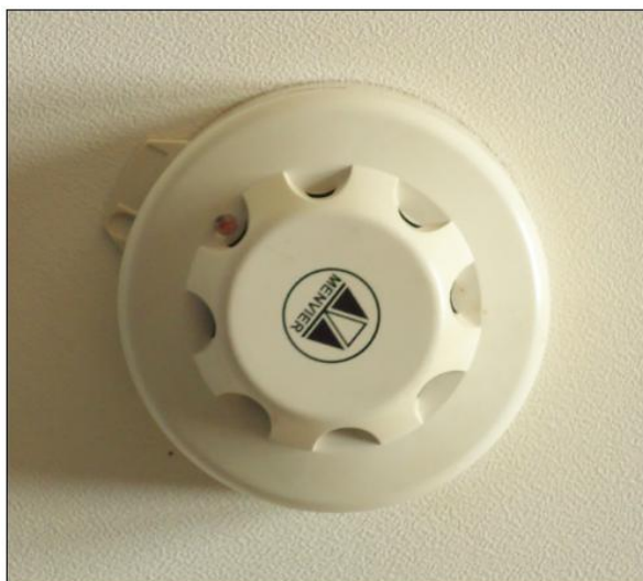
Εικόνα 5.1: Αισθητήρας πυρανίχνευσης Εικόνα 5.2: Πίνακας πυρανίχνευσης
