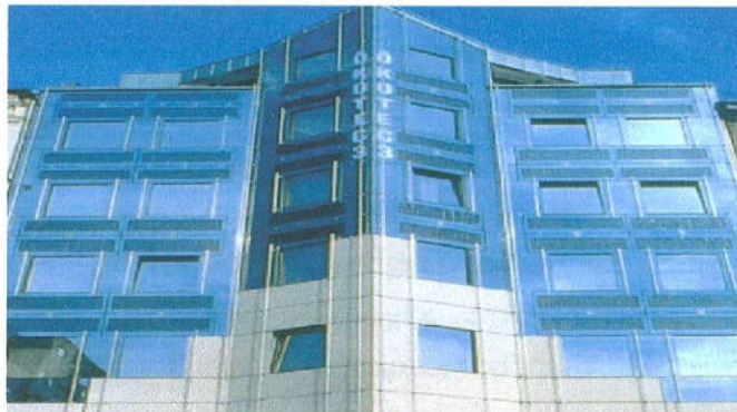
Κτίριο γραφείων, Βερολίνο (Photovoltaics in buildings, 1996). Γενική όψη (δεξιά), λεπτομέρεια των στοιχείων (αριστερά). Συνολικό εμβαδόν 64\text{m}^2 από 44 στοιχεία, με συνολική ισχύ 4,2 KW.
