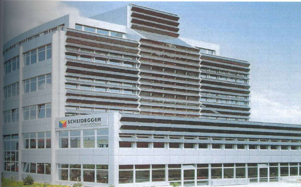
Σχήμα 2.7.4.: Κτίριο γραφείων, Kirchberg, Ελβετία (Photovoltaics in buildings, 1996). Συνολικό εμβαδόν 170m 2 , με συνολική ισχύ 18KW. Τα φωτοβολταϊκά συνεισφέρουν και στην ηλιοπροστασία των ανοιγμάτων. Πηγή: ΜΠΑΛΛΑΡΑΣ Κ.Α., 2002.
