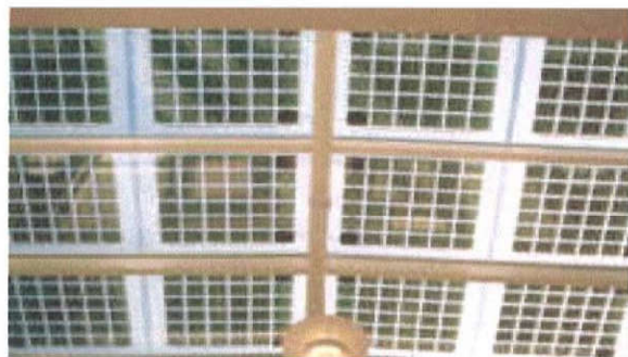
β) εσωτερική όψη
