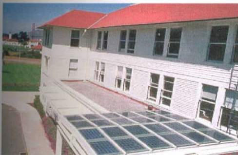
α) εξωτερική όψη
