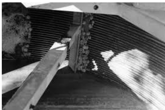
Εικόνα 3.1: Σχάρα απομάκρυνσης στερεών
