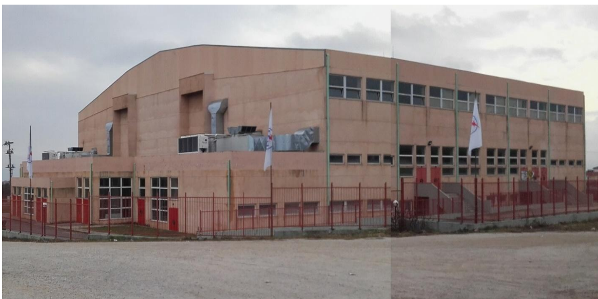
Σχήμα 4. 1: Γενική άποψη γυμναστηρίου
