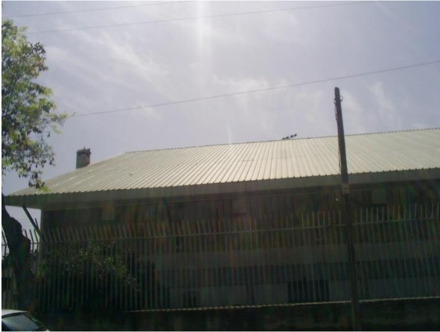
Εικόνα 4 – Άποψη της στέγης του κολυμβητηρίου
