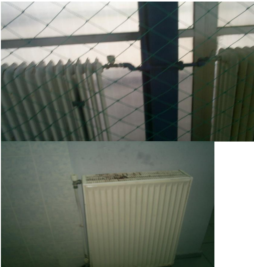
Εικόνα 6 – Τερματικές θερμαντικές μονάδες
