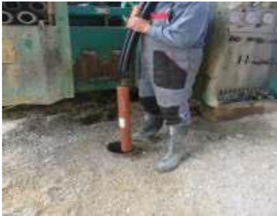
β) Εισαγωγή σωλήνων στη γεώτρηση
