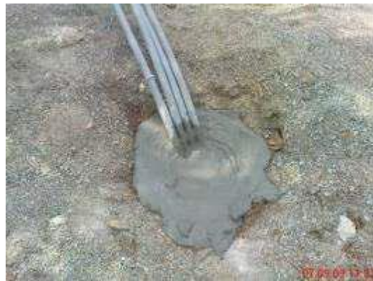
γ) Εισαγωγή ενέματος και κλείσιμο γεώτρησης
