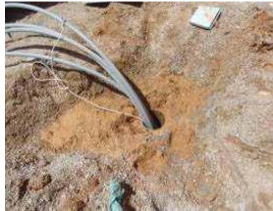
β) Εισαγωγή σωλήνων στη γεώτρηση
