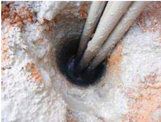
γ) Εισαγωγή ενέματος και κλείσιμο γεώτρησης
