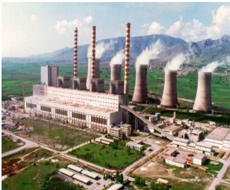
ΣΧΗΜΑ 11: ΑΤΜΟΗΛΕΚΤΡΙΚΟΣ ΣΤΑΘΜΟΣ ΑΓΙΟΥ ΔΗΜΗΤΡΙΟΥ (Πηγή:google.gr)
