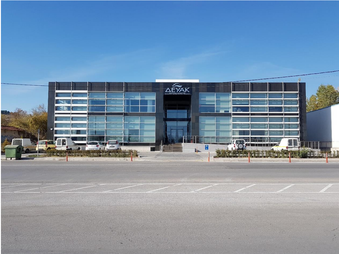
Εικόνα 4.7: Το κτίριο της ΔΕΥΑΚ (Νότια Όψη)
