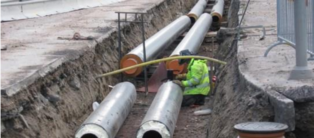
Εικόνα 2.9: Εργασίες εγκατάστασης προμονωμένων αγωγών τηλεθέρμανσης/τηλεψύξης [54]
