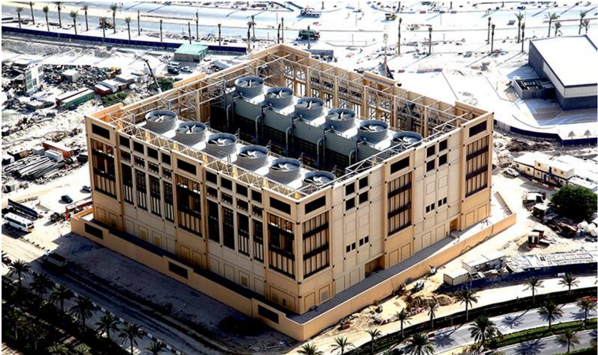
Εικόνα 1.2: Σταθμός τηλεψύξης στο Άμπου Ντάμπι [15]
