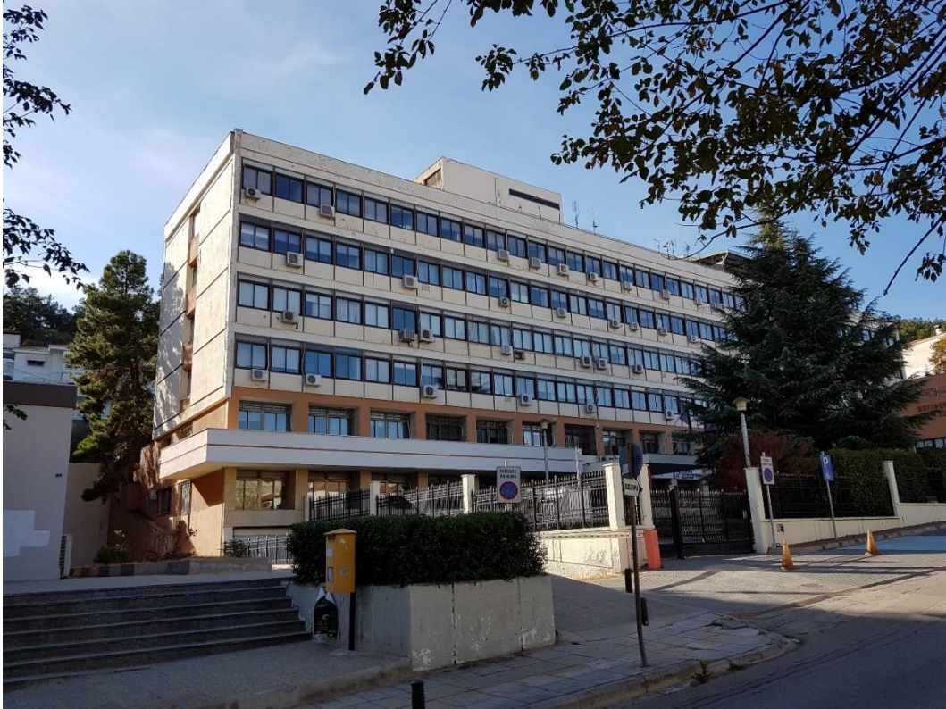
Εικόνα 4.5: Το κτίριο της Περιφερειακής Ενότητας Κοζάνης
