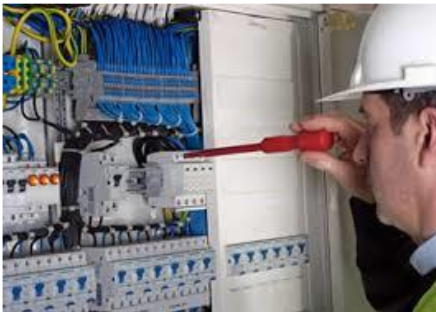
Εικόνα 10. Επισκευή Πίνακα Ελέγχου
