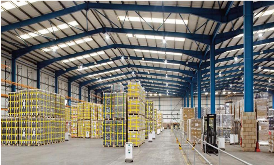
Εικόνα 20. Φωτισμός Σε Μεγάλο Βιομηχανικό Χώρο
