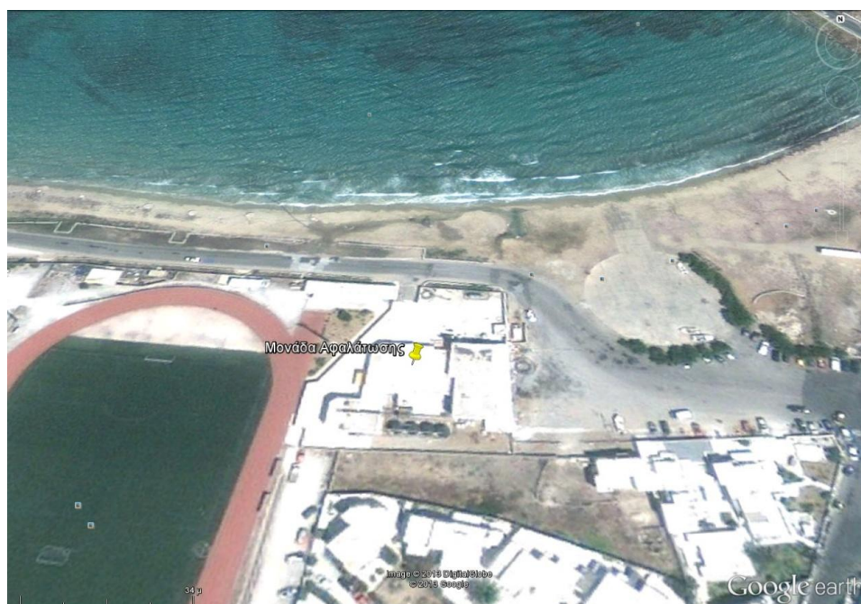
Εικόνα 3.13: μονάδα αφαλάτωσης Μυκόνου από Google earth
