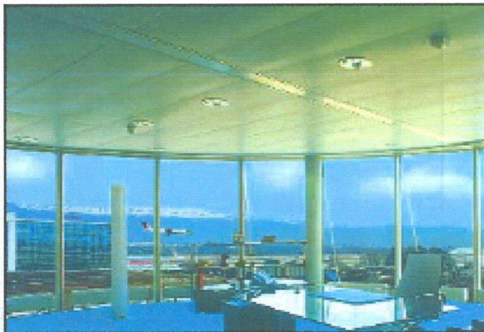
Σχήμα 10. Η οροφή δροσίσιμου δεν αποτελεί αντιαισθητική λύση στο πρόβλημα του κλιματισμού
