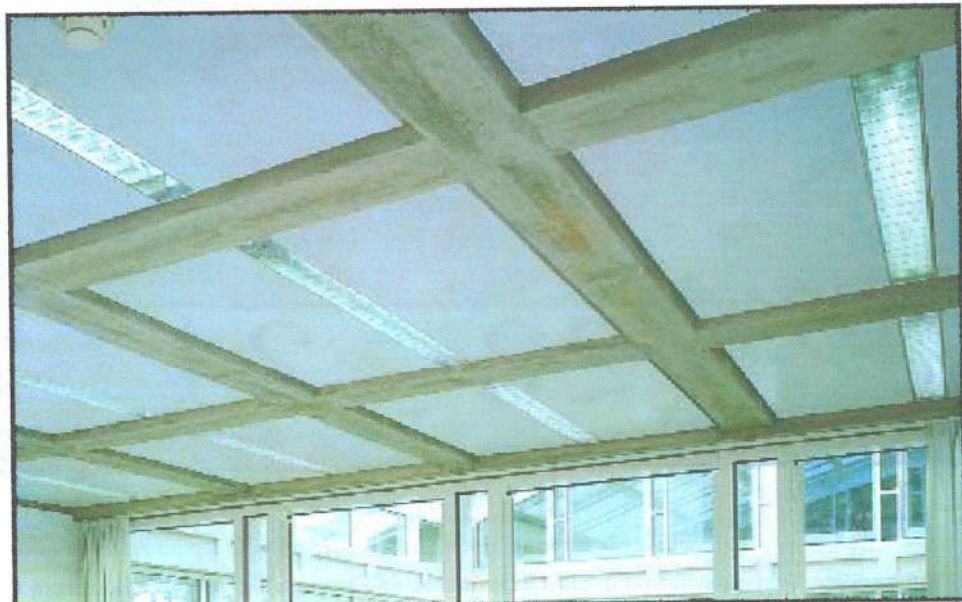
Σχήμα 9. Πανέλα εμβαπτισμένα στον φέροντα οργανισμό του κτιρίου (σκυρόδεμα)
