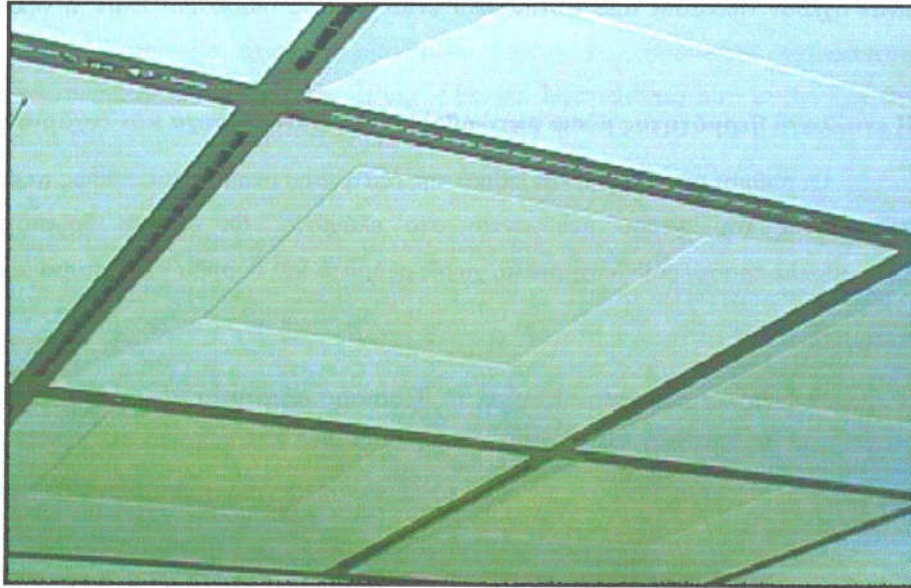
Σχήμα 6. Συναρμογή πανέλων
