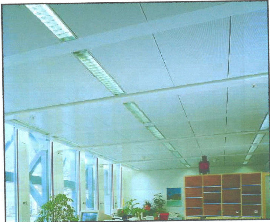
Σχήμα 11. Η ένταξη των οροφών δροσισμού στο χώρο γίνεται χωρίς να επηρεάζονται τα υπόλοιπα στοιχεία του χώρου (όπως γίνεται με τα κλιματιστικά)
