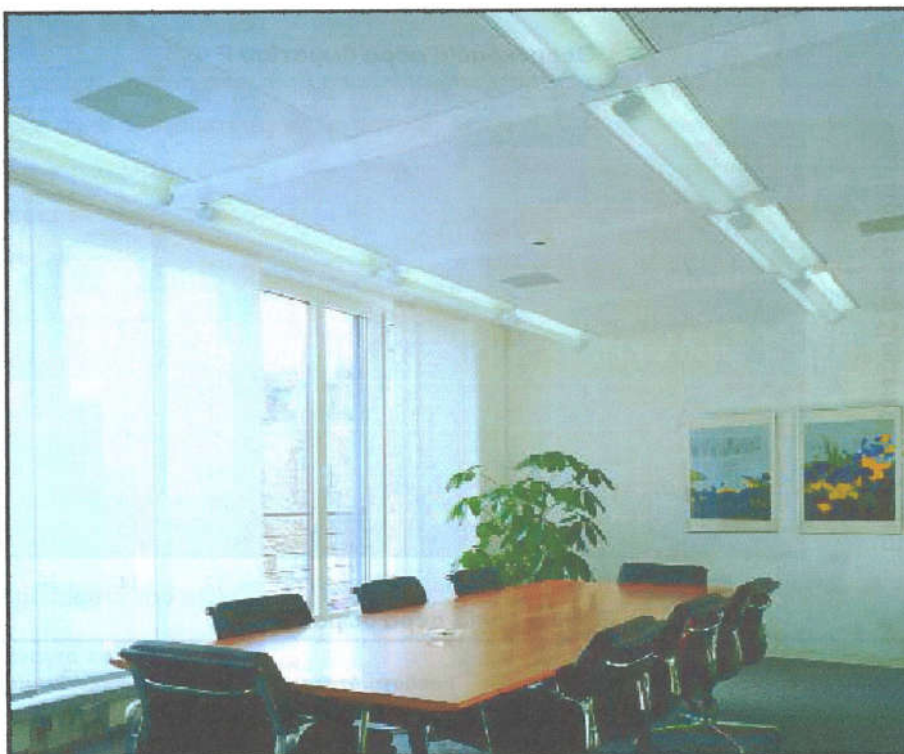
Σχήμα 5. Πανέλα δροσισμού σε χώρο γραφείου
