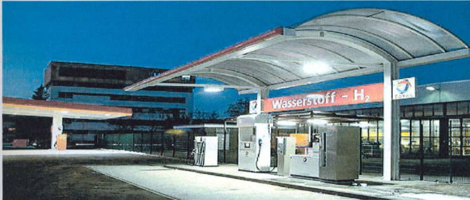
Εικόνα 8.: Σταθμός ανεφοδιασμού υδρογόνου στο Spandau του Βερολίνου στη Γερμανία [21].
