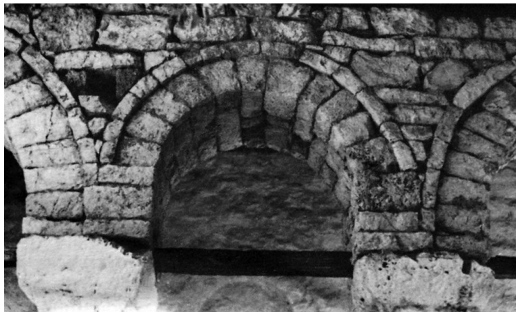
Μονή Σωσίνου - Καθολικό: Τόξο στον εξωνάρθηκα (φωτογραφία Ρέας Στυλιανού, 1981, Εκκλησίες στην Ελλάδα μετά την Άλωση , σ. 76).
