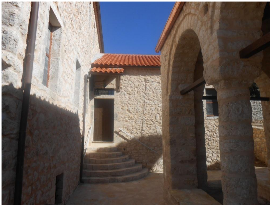
Πέτρινη ημικυκλική σκάλα με έξι σκαλοπάτια, που οδηγεί στα κελιά υπερυψωμένου ισογείου στο Σώσινο μετά τα έργα αναστήλωσης (φωτογραφία Ευτυχίας Μπούμπα).
