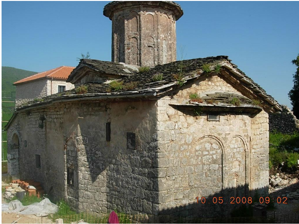
Το Καθολικό της Ιεράς Μονής πριν από την ανακαίνισή του με τη χορταριασμένη πλακόστρωτη στέγη του (φωτογραφία Ευτυχίας Μπούμπα).
