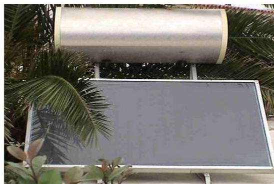
Σχήμα 2.10- Ηλιακός θερμοσίφωνας επίπεδου συλλέκτη
