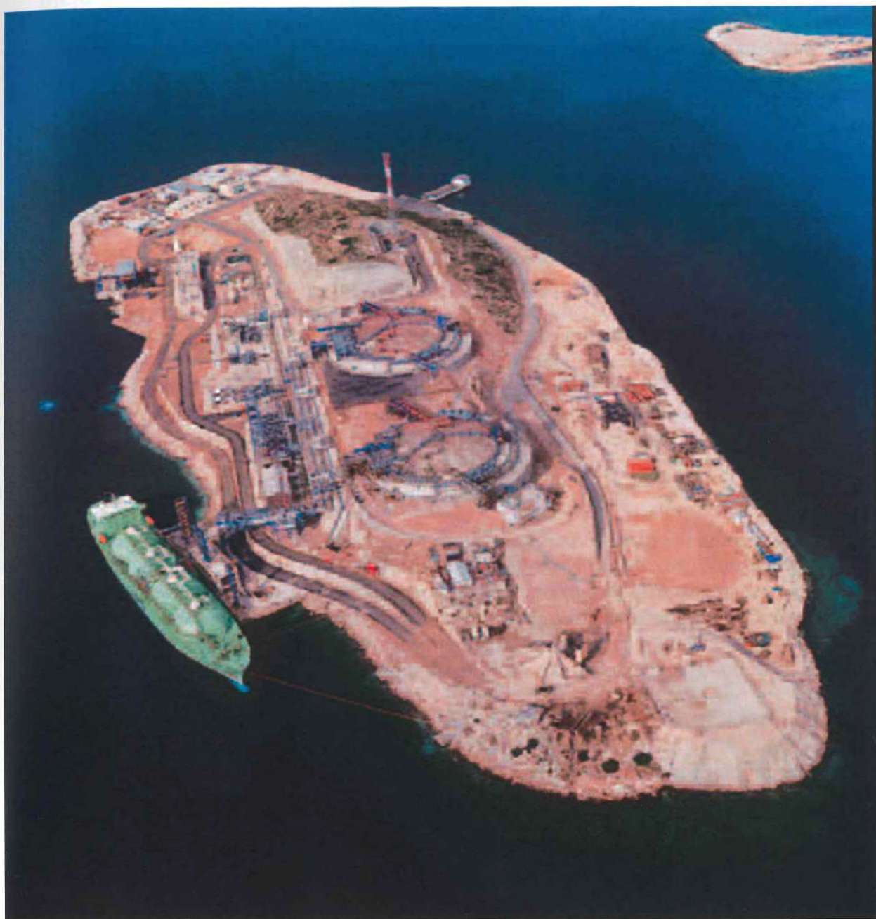
Εικόνα 3. Ο τερματικός σταθμός της Ρεβυθούσας
