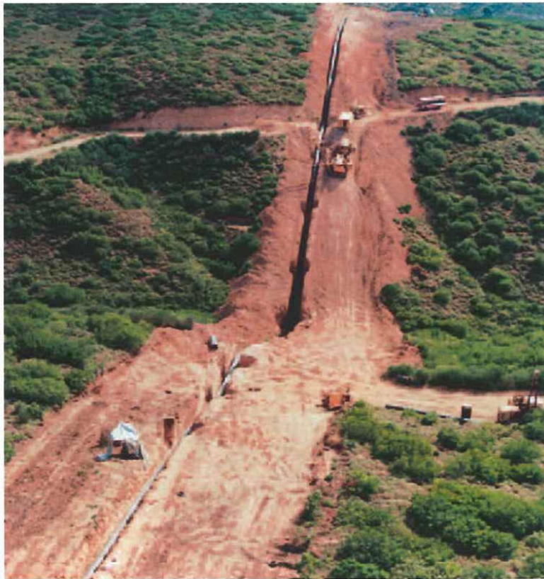
Εικόνα 1. Κατασκευή του αγωγού μεταφοράς αερίου
