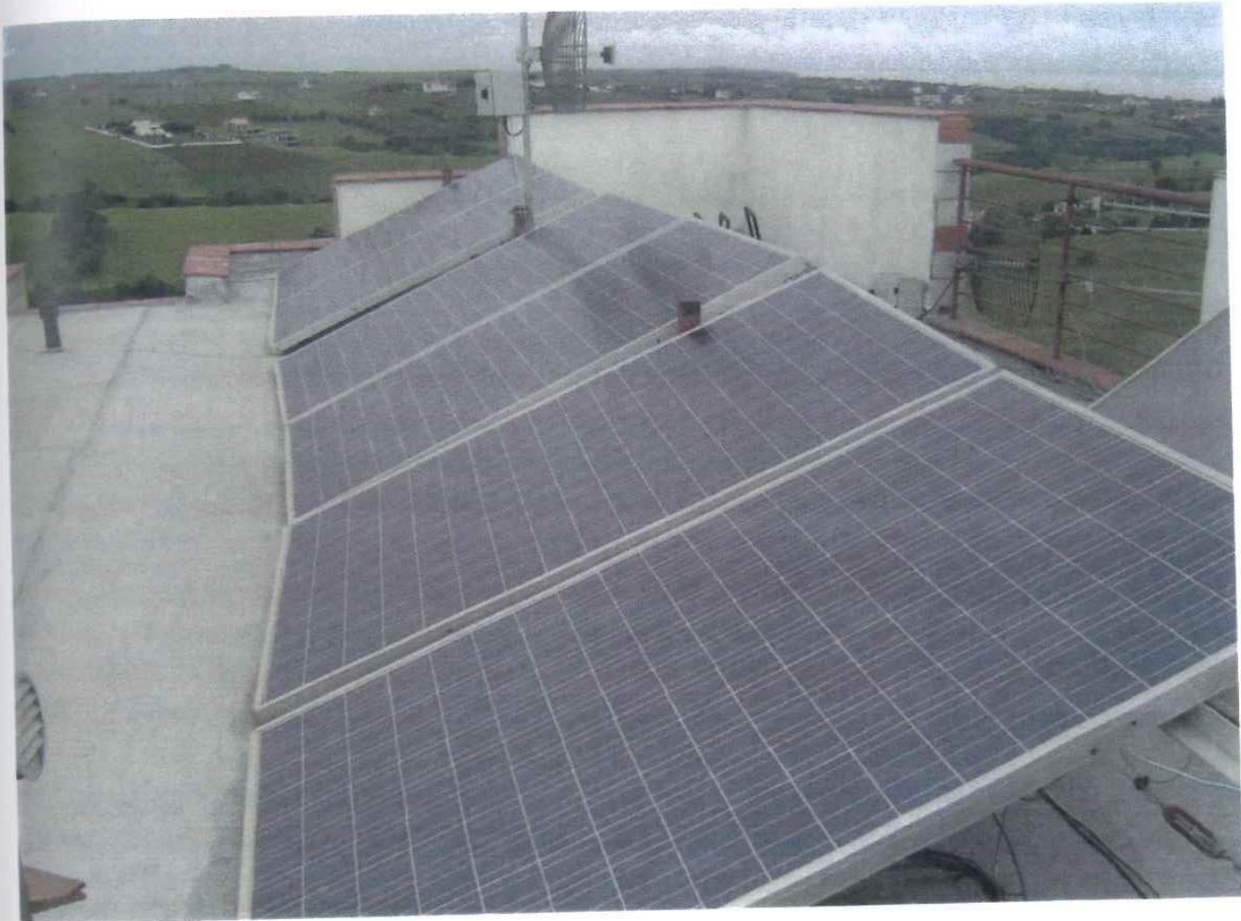
Σχήμα 5.6: Διασυνδεδεμένο φωτοβολταϊκό σύστημα πολυκρυσταλλικού πυριτίου στην ταράτσα της κατοικίας
