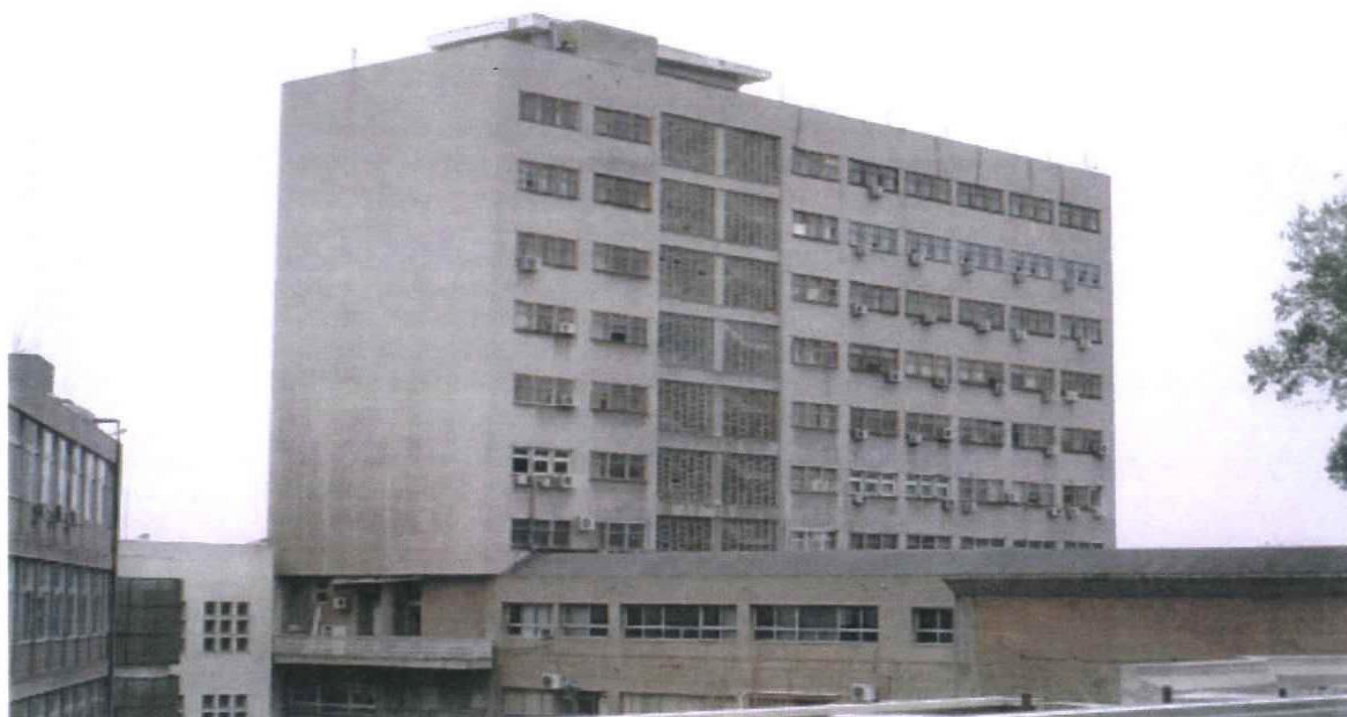
Σχήμα 6.7: Βόρεια όψη κτιρίου εδρών.
