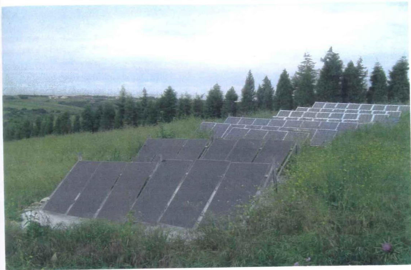
Σχήμα 5.7: Διασυνδεδεμένες φωτοβολταϊκές διατάξεις άμορφου, πολυκρυσταλλικού και μονοκρυσταλλικού πυριτίου στην αυλή της κατοικίας.
