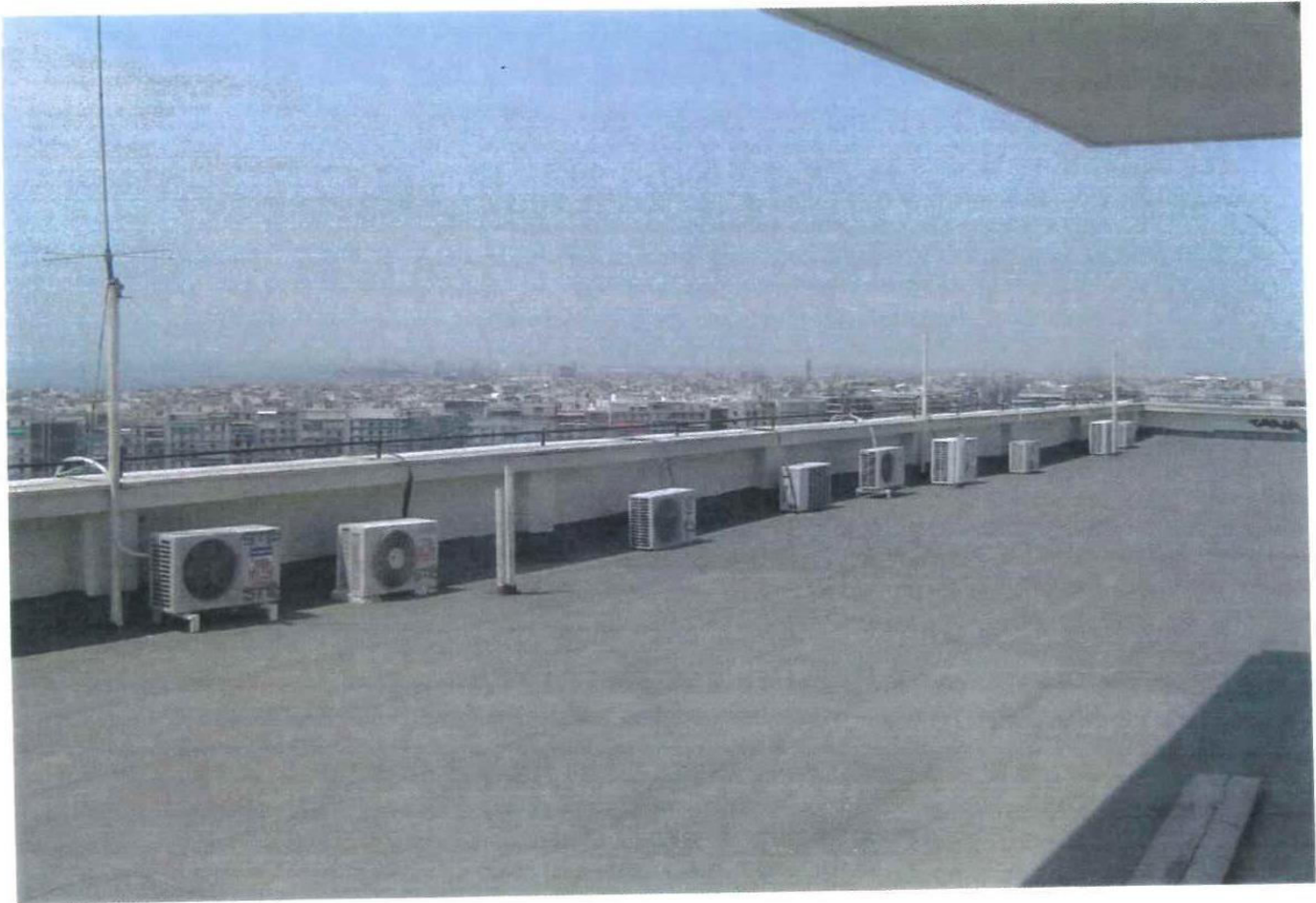
Σχήμα 6.9: Δώμα κτιρίου εδρών.
