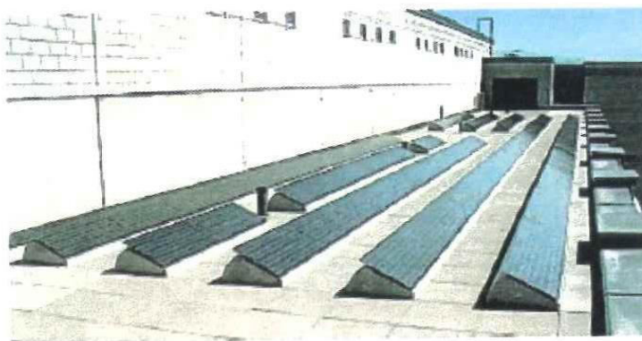
Σχήμα 2.25: Εφαρμογή BIPV σε επίπεδη στέγη
