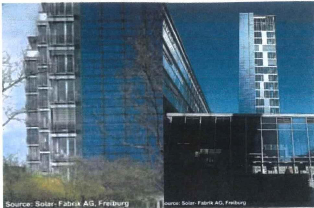
Σχήμα 2.24: Εφαρμογή BIPV σε προσόψεις κτιρίων
