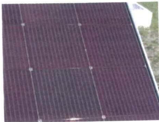
Σχήμα 2.10: Άμορφο πυρίτιο
