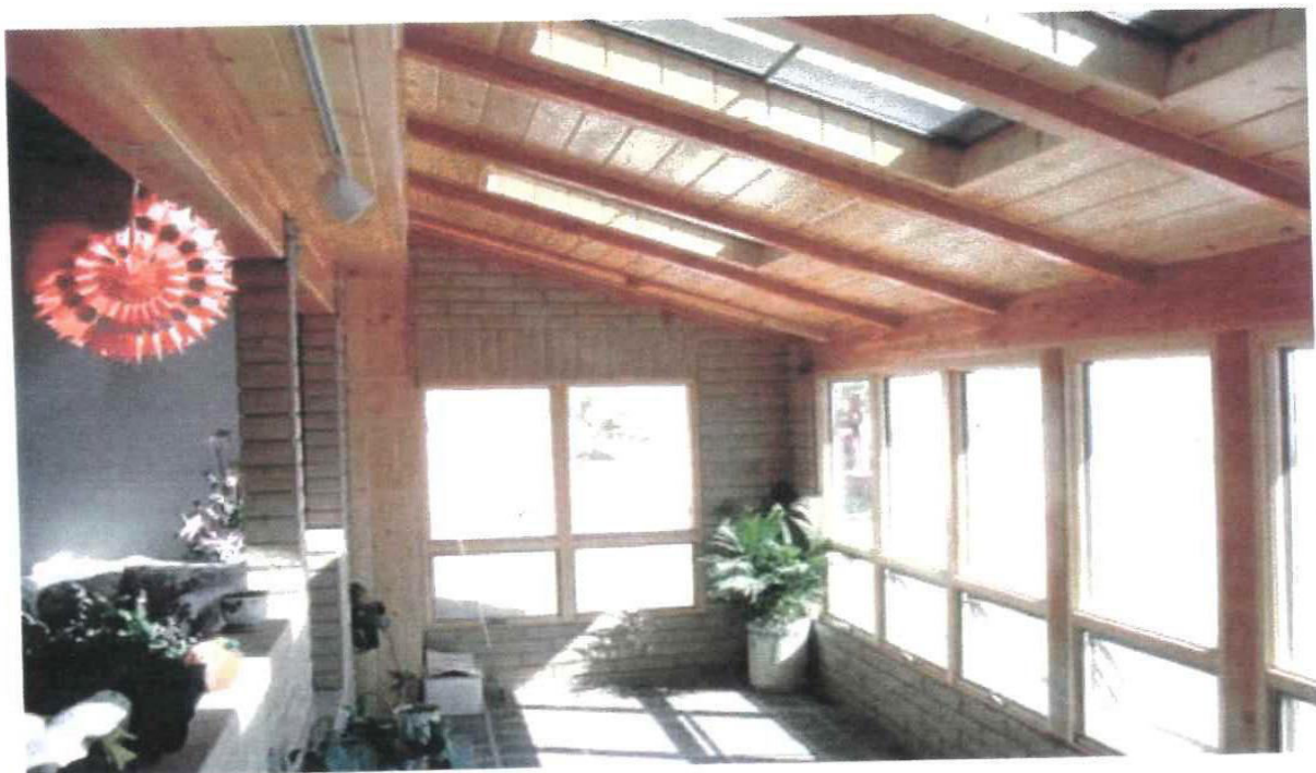
Σχήμα 1.1: Παθητικό ηλιακό σύστημα
