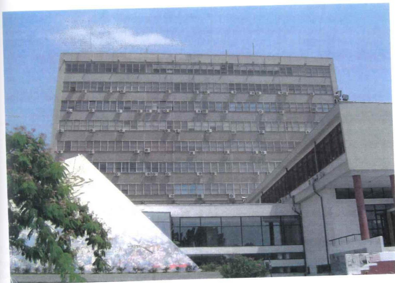
Σχήμα 6.3: Νότια όψη κτιρίου εδρών.
